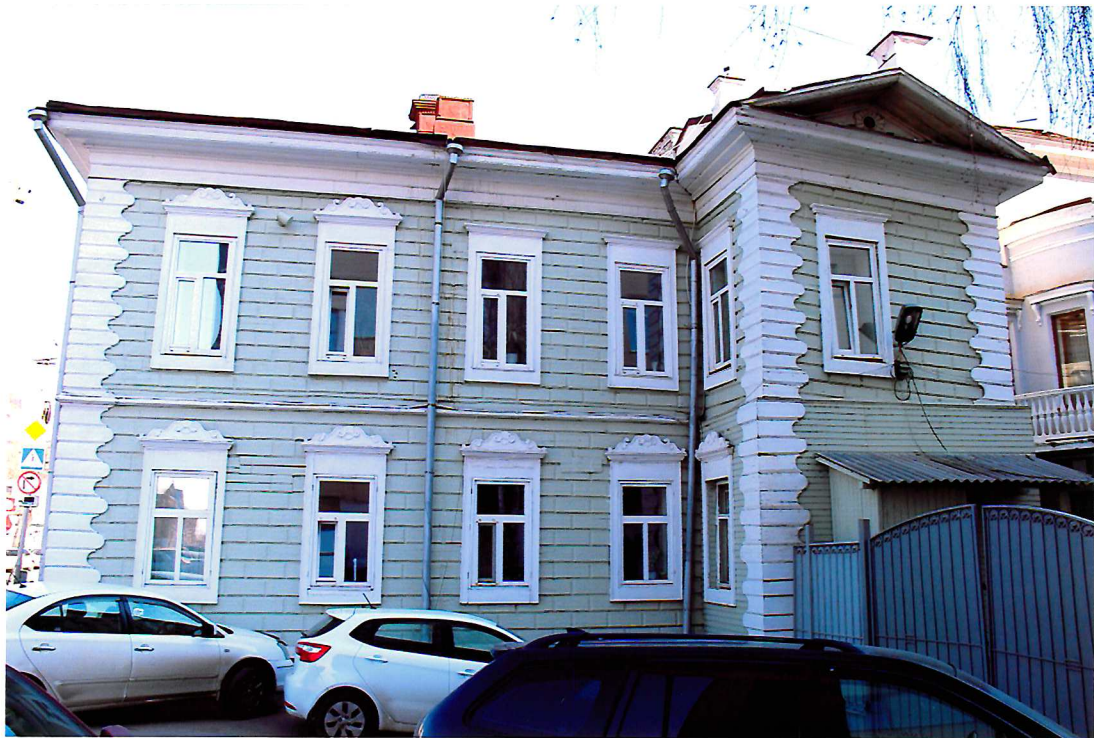
Видовая точка № 3. Южный фасад здания. Автор снимка: Однокопылова О.А., дата снимка: 08.04.2016 г.
