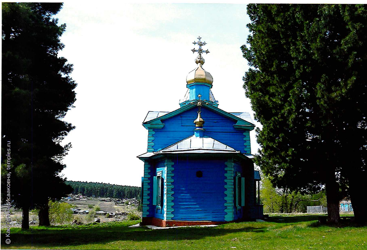
Видовая точка № 5. Восточный фасад церкви (автор снимка: Кан Г.И., дата съемки: 17.05.2015 г.).
