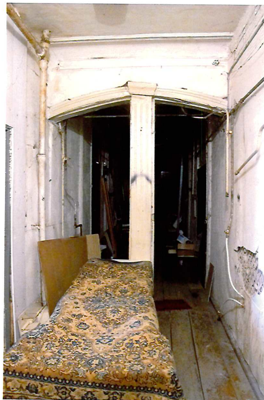
Видовая точка № 8. Интерьер 1-го этажа. Лучковая арка с колонной по центру.
