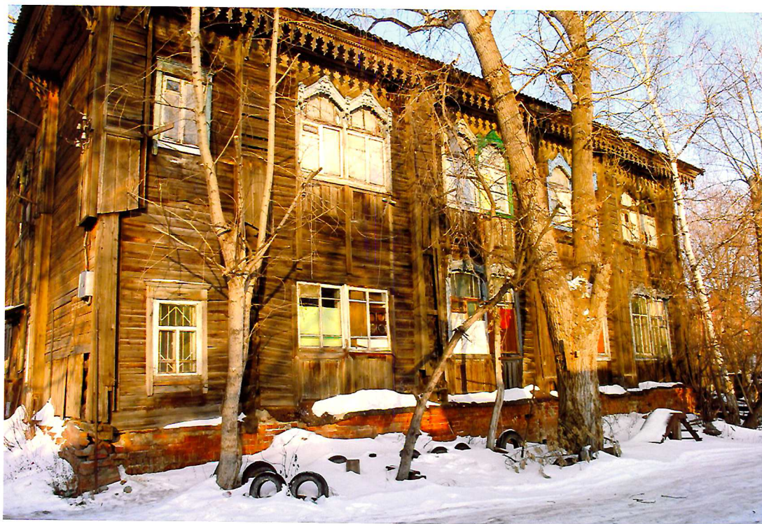
Видовая точка № 3. Южный фасад здания.
