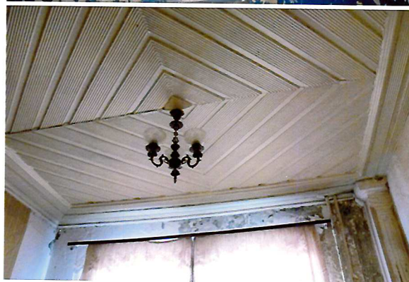
Видовые точки № 12, 13. Профильные тяги и профильная обшивка в оформлении потолков 1-го этажа.
