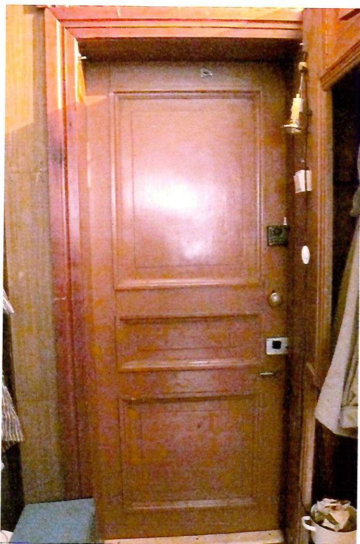
Видовая точка № 11. Филенчатая дверь в помещении 1-го этажа.
