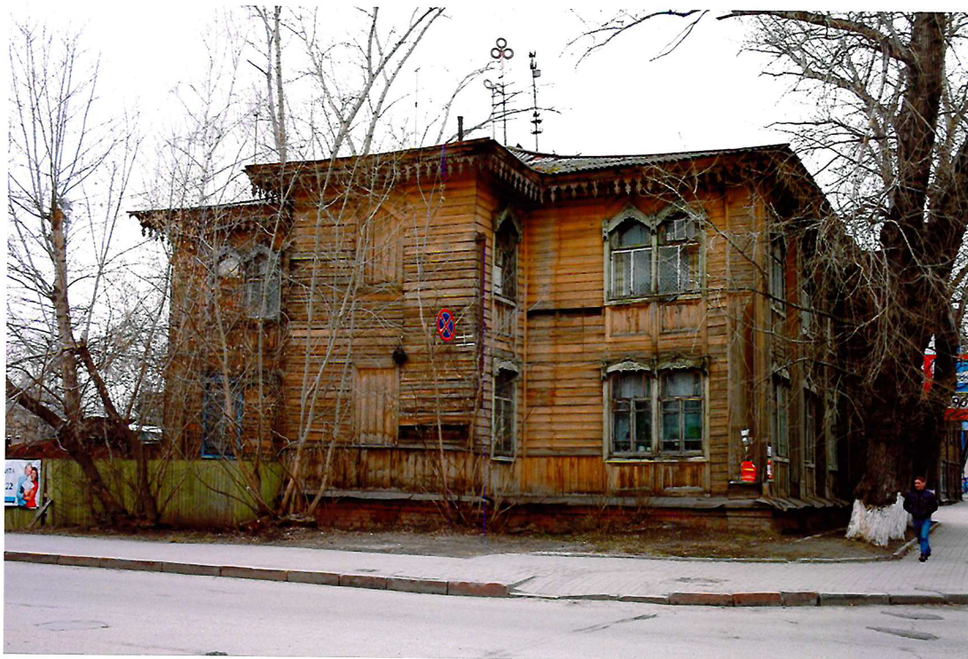
Видовая точка № 5. Восточный фасад здания. Автор снимка: О.Г. Литвинова, дата съемки: 23.04.2012 г.
