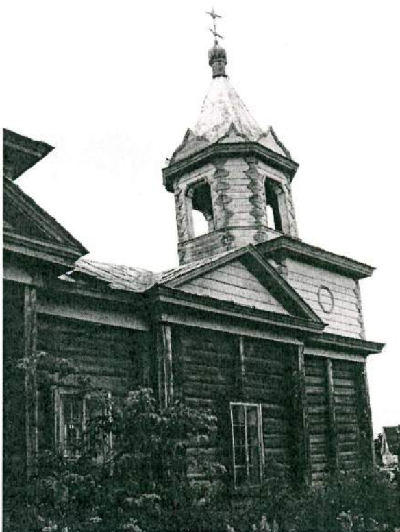
Видовая точка № 5. Фрагмент северного фасада.
