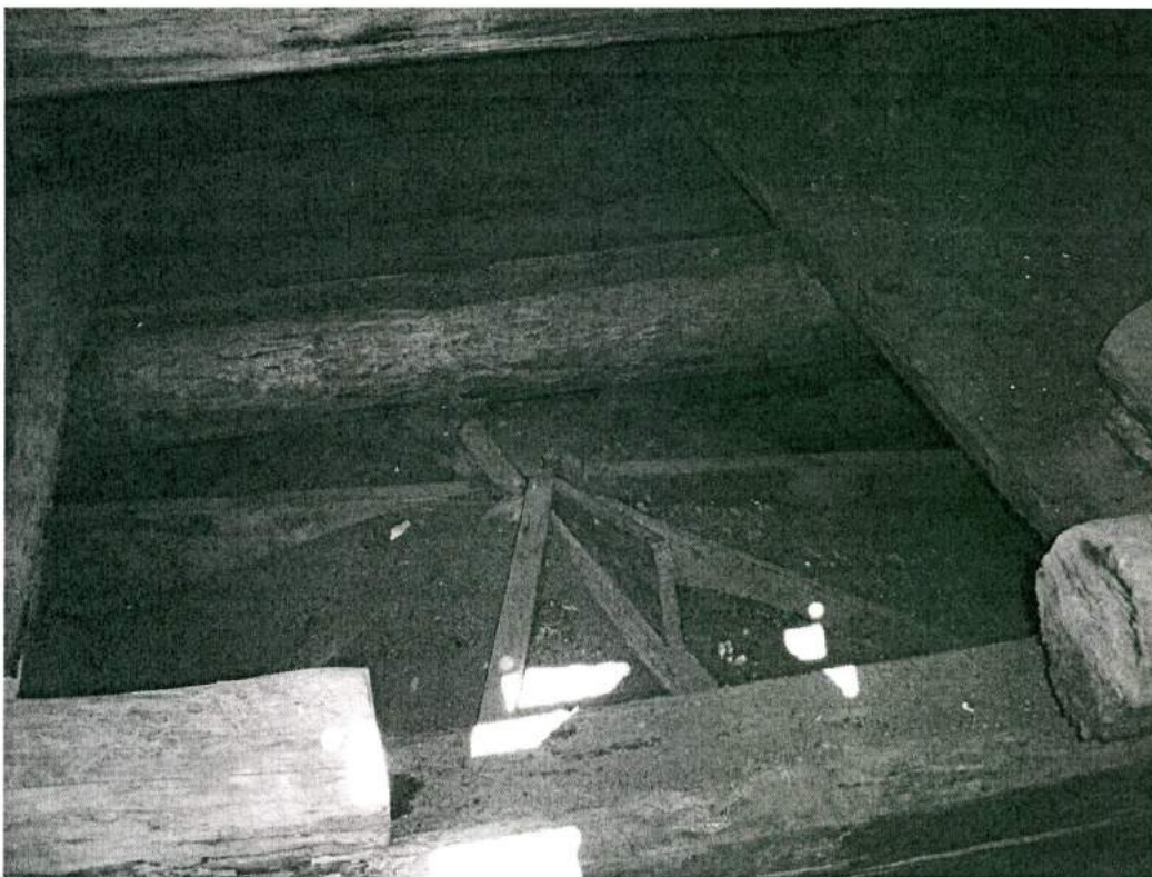
Видовая точка № 18. Чердак над помещением храмовой части церкви. Конструкция деревянного свода.
