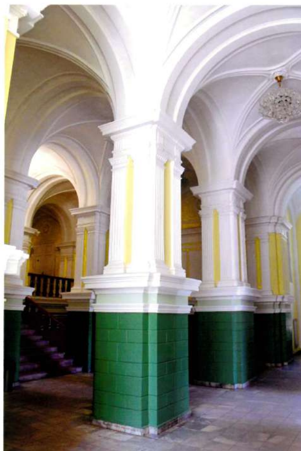
Видовая точка № 32. Оформление вестибюля. Столбы, своды, профильный декор.
