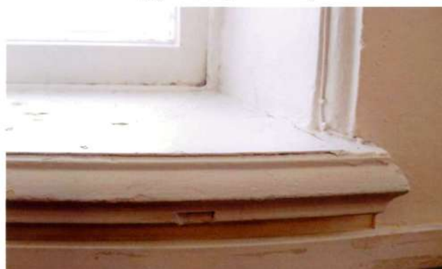
Видовая точка № 24. Профильный деревянный подоконник.
