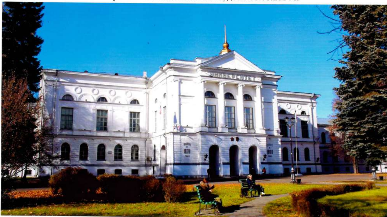
Видовая точка № 1. Фрагмент главного (восточного) фасада. Центральная часть .
