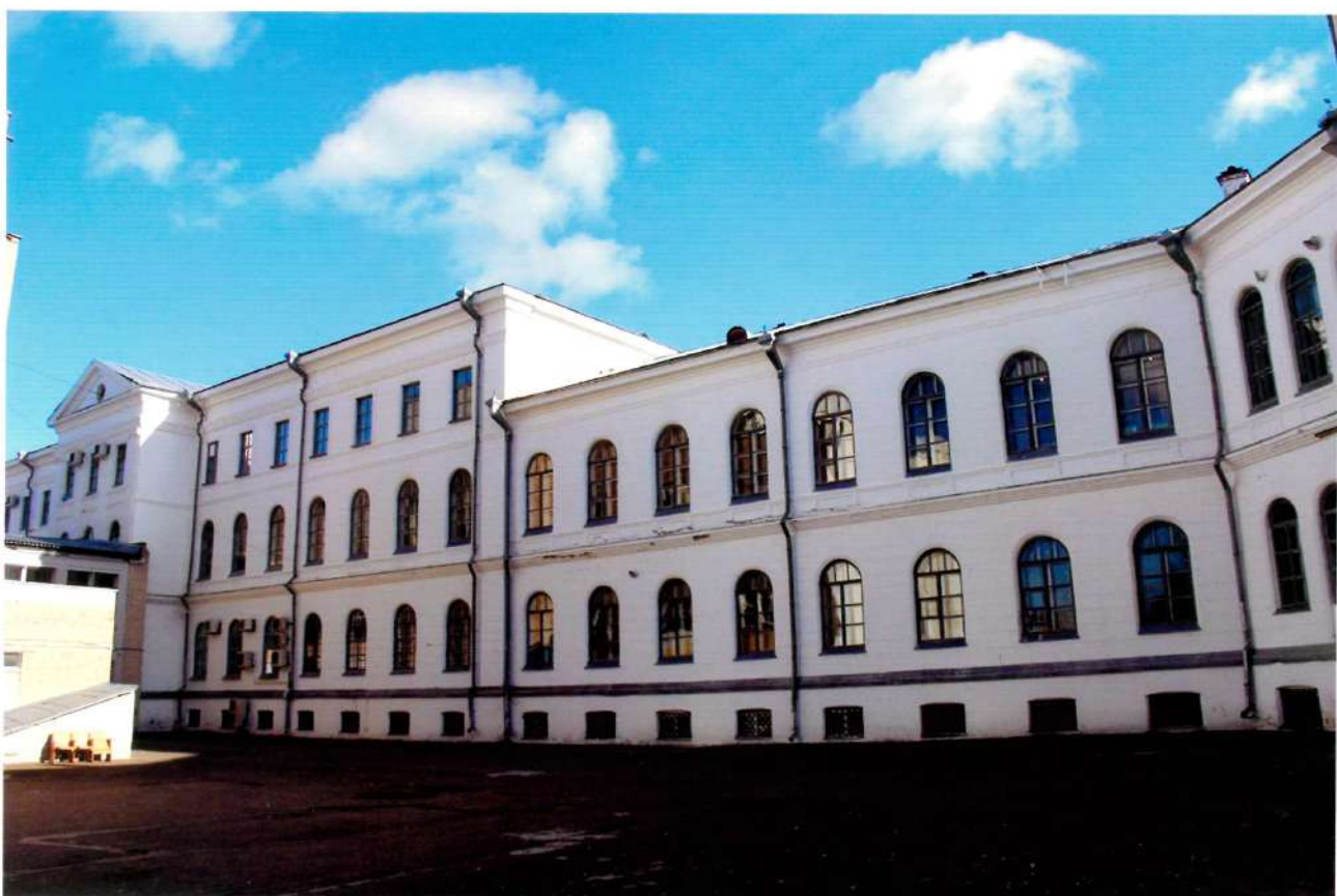
Видовая точка № 10. Фрагмент дворового фасада. Центральная часть здания.
