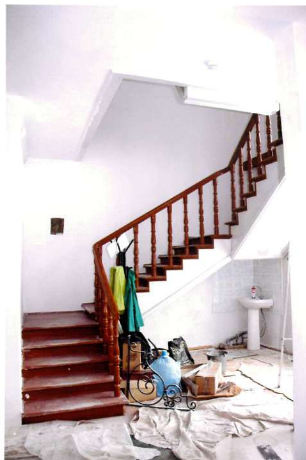
Видовая точка № 51. 3-х маршевая деревянная лестница.
