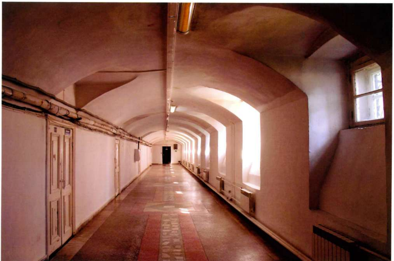
Видовая точка № 12. Фрагмент цокольного этажа. Коридор.
