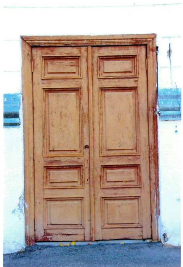
Видовая точка № 7. Филенчатая двухстворчатая дверь. Боковое (южное) крыло здания. Дворовый фасад.
