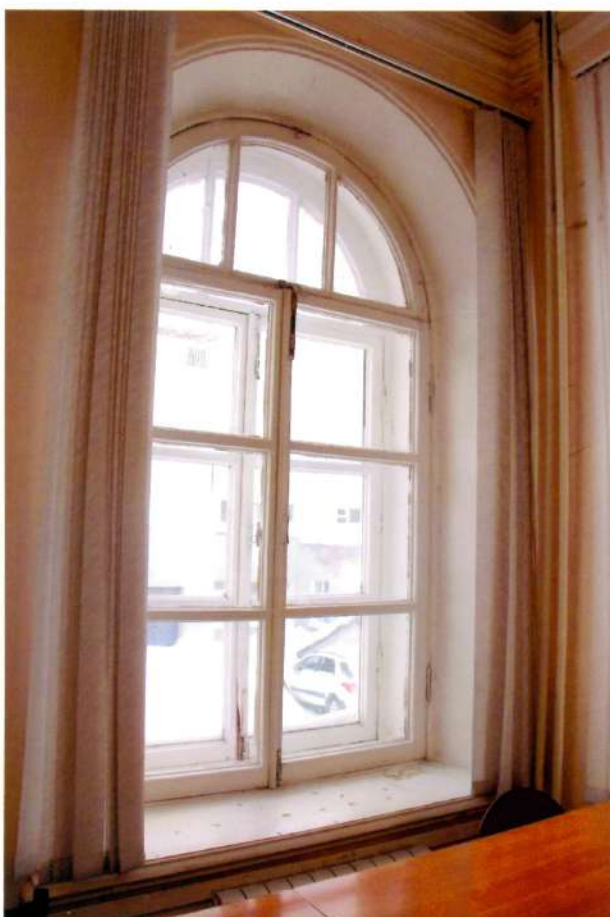
Видовая точка № 21. Деревянное оконное заполнение 1-го этажа.
