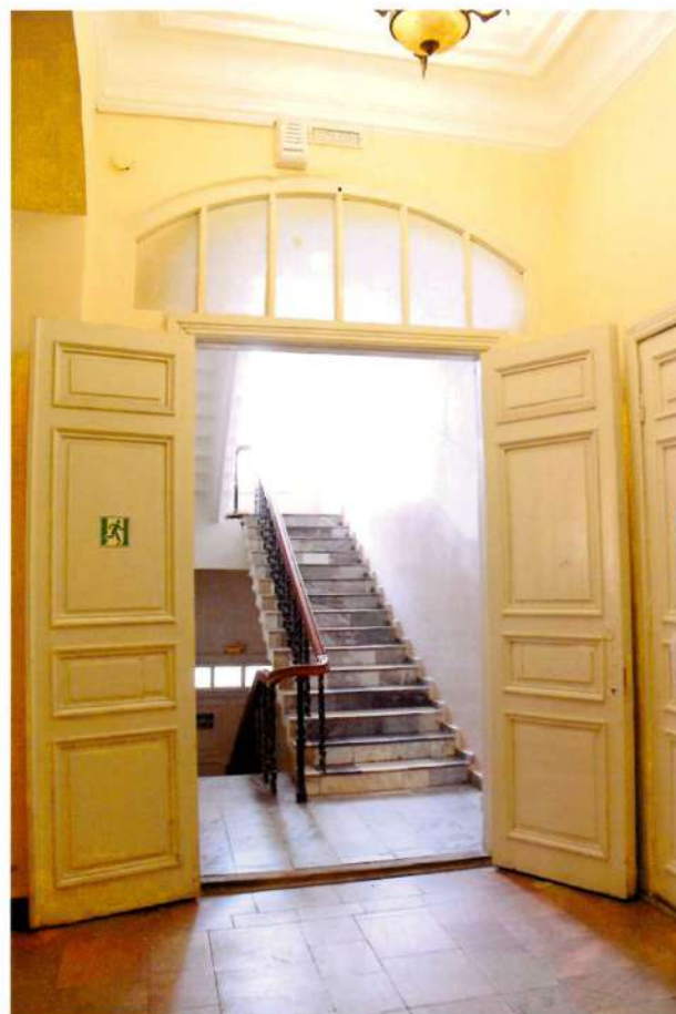
Видовая точка № 20. Деревянная филенчатая дверь с остекленной фрамугой.
