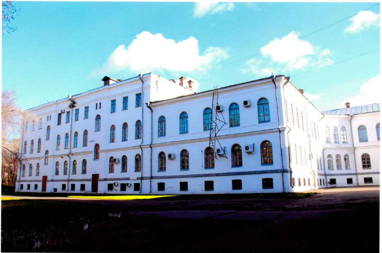
Видовая точка № 11. Фрагмент дворового фасада. 3-х этажный объем (северное крыло).
