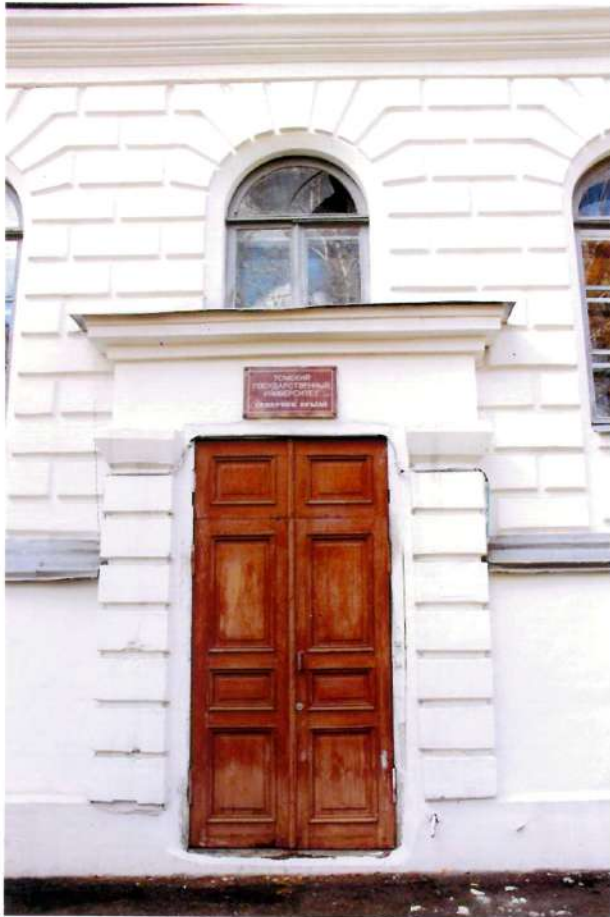
Видовая точка № 6. Вход с порталом. Боковое (северное) крыло здания. Главный фасад.
