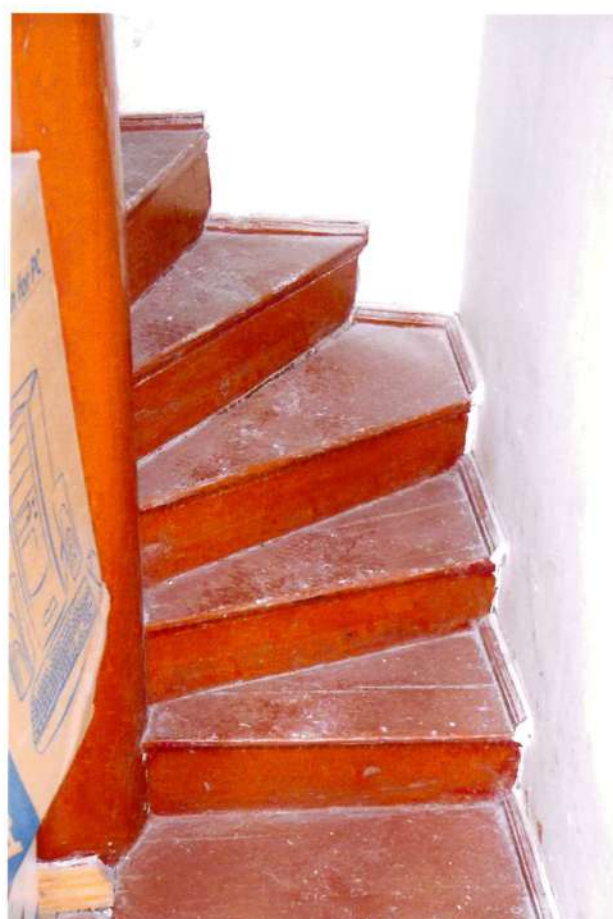
Видовая точка № 53. Винтовая деревянная лестница.
