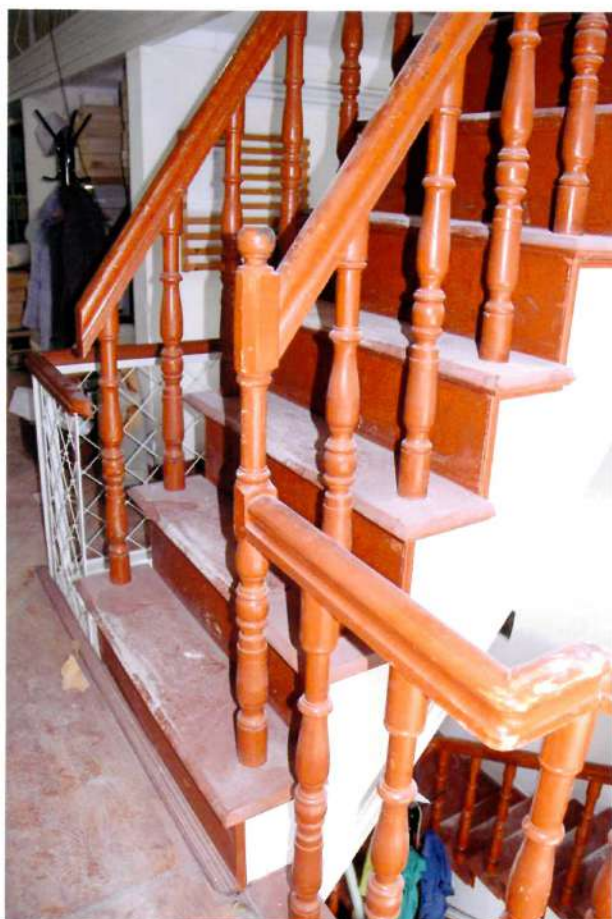
Видовая точка № 52. 3-х маршевая деревянная лестница. Фрагмент.
