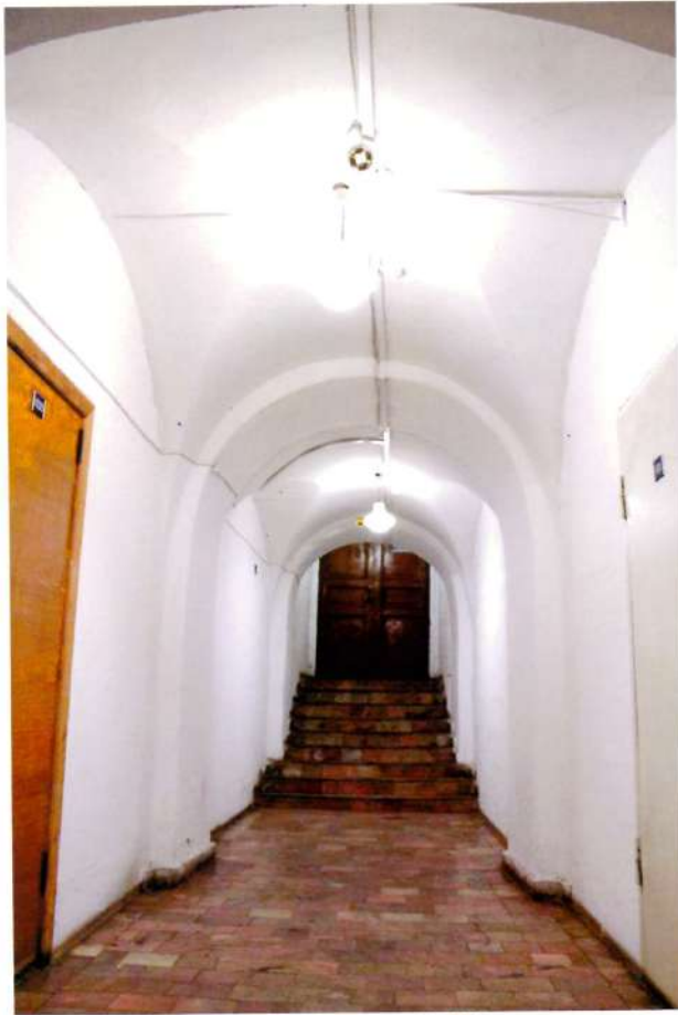
Видовая точка № 13. Общий вид коридора цокольного этажа.
