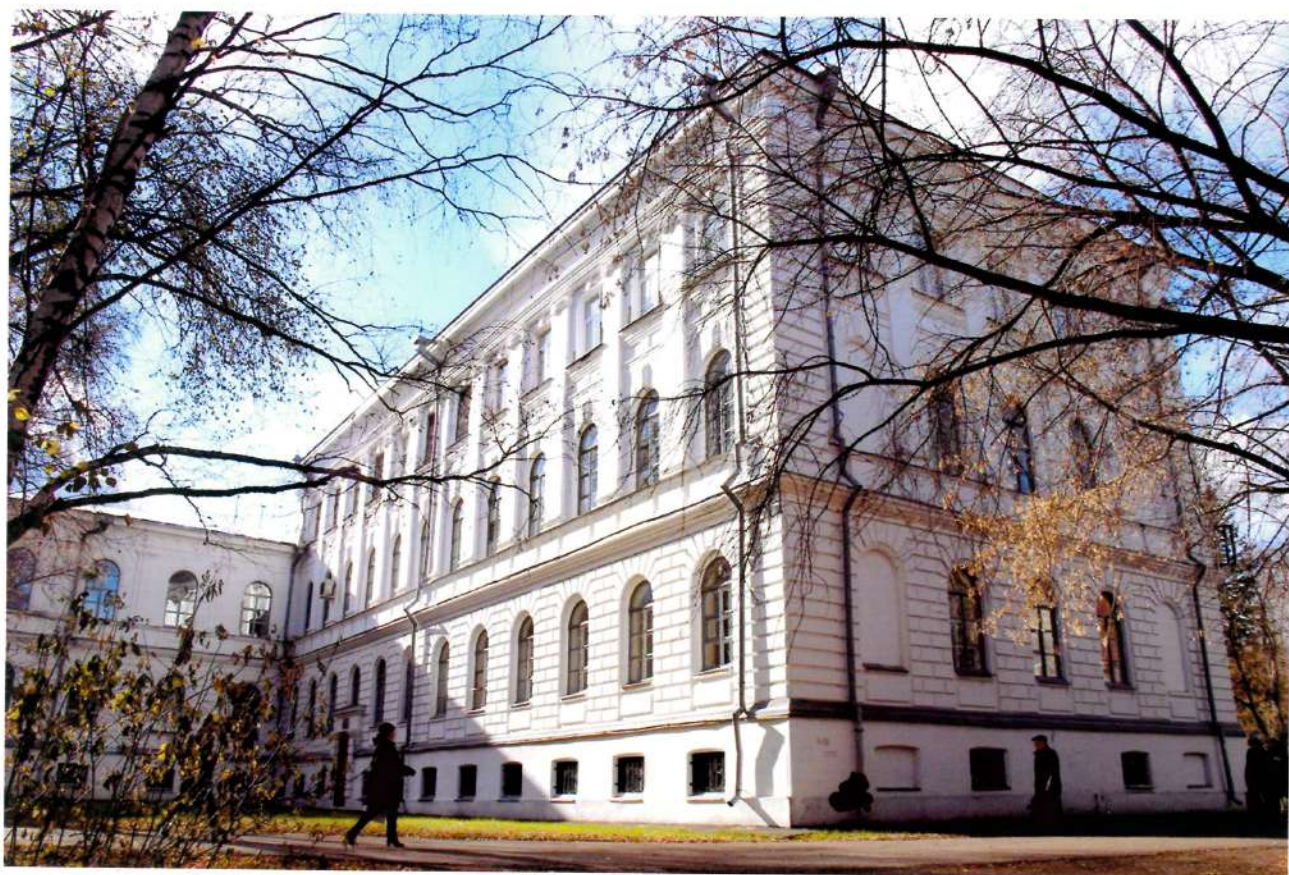
Видовая точка № 5. Фрагмент главного (восточного) фасада. 3-х этажный объем (северное крыло).
