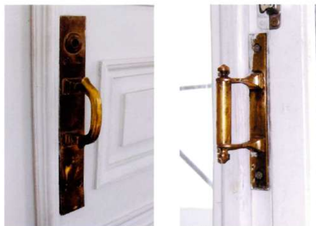
Видовая точка № 22 и 23. Восстановленная скобяная фурнитура из латуни (ручка двери и окна).
