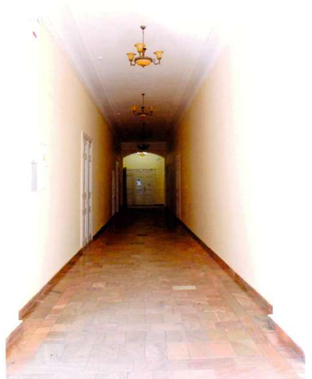
Видовая точка № 16. Коридор 2-го этажа. Плоские перекрытия. Лучковые арки.
