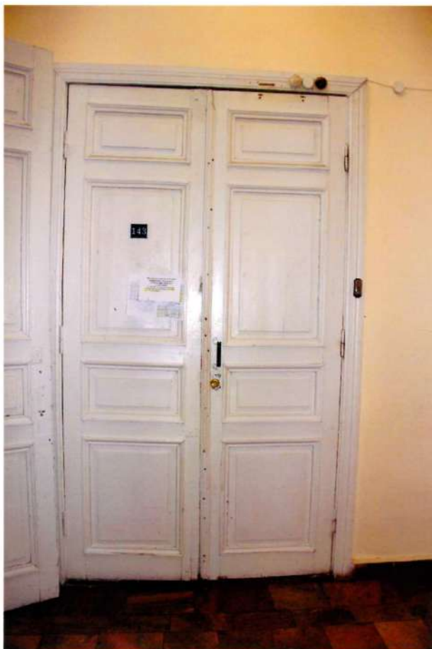
Видовая точка № 19. Деревянная филенчатая дверь.
