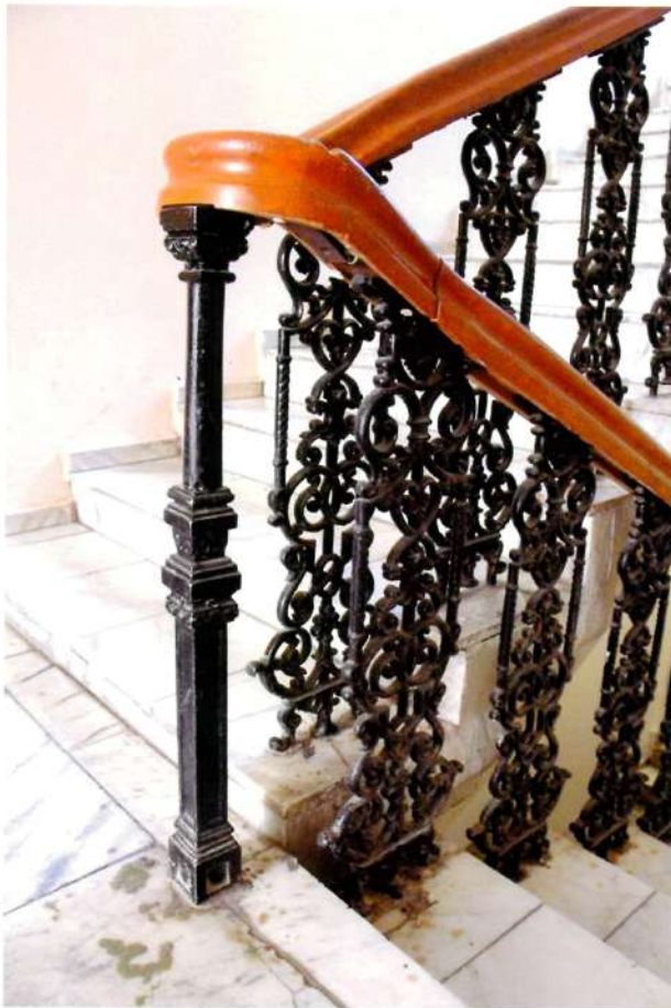
Видовая точка № 28. Металлическое ограждение лестницы (литье).
