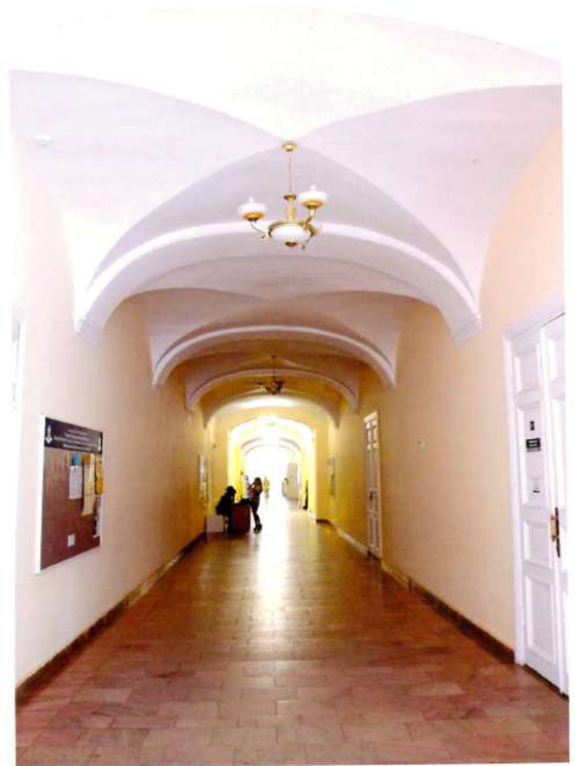
Видовая точка № 14. Коридор 1-го этажа. Крестовые своды перекрытия.
