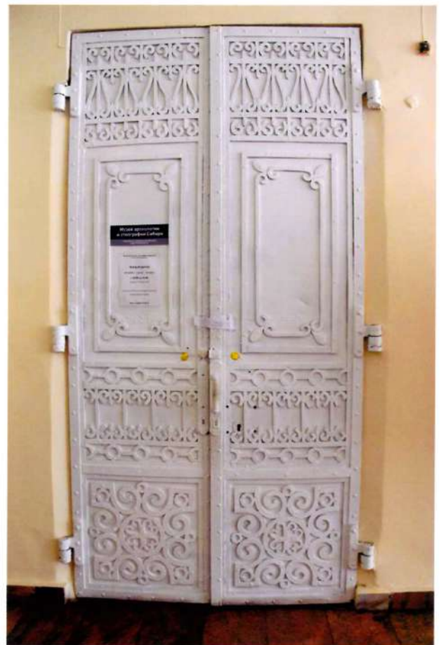
Видовая точка № 49. Металлические ставни на навесах (ковка).
