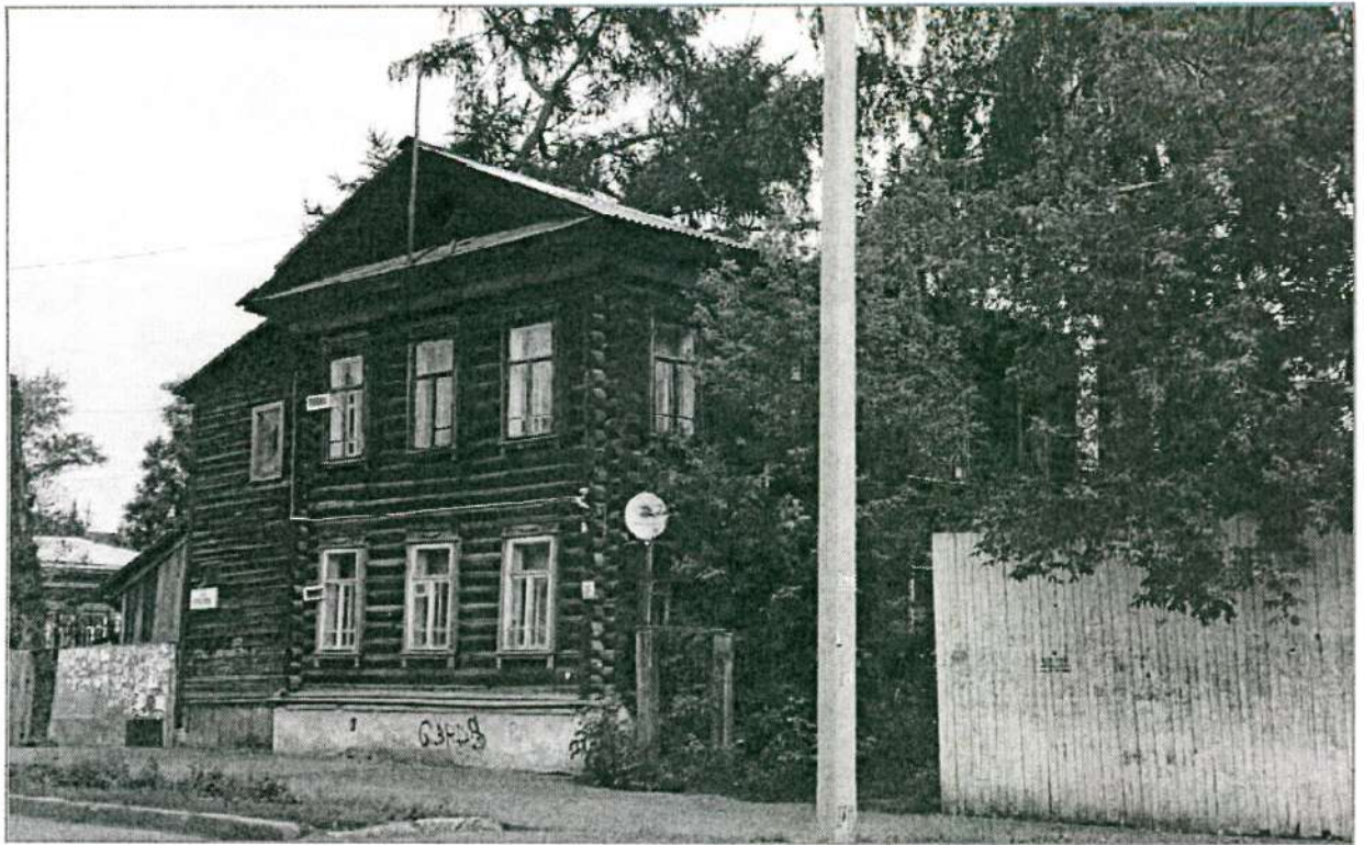
Фото 5. Вид на «Дом-флигель усадьбы купца С.Ф. Хромова и его наследников», по ул. Крылова, 26а в г. Томске. Восточный фасад. По состоянию на 2017 г.
