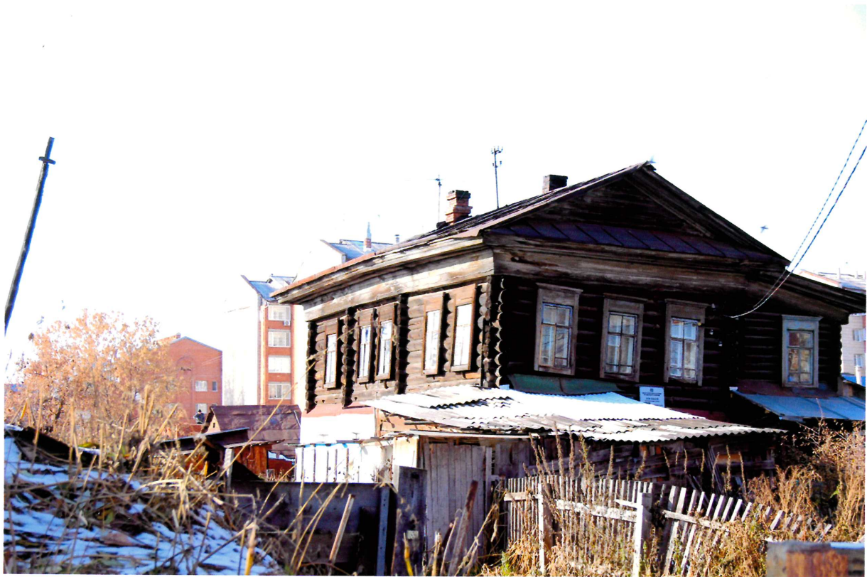
Видовая точка № 7. Южный и восточный фасады.
