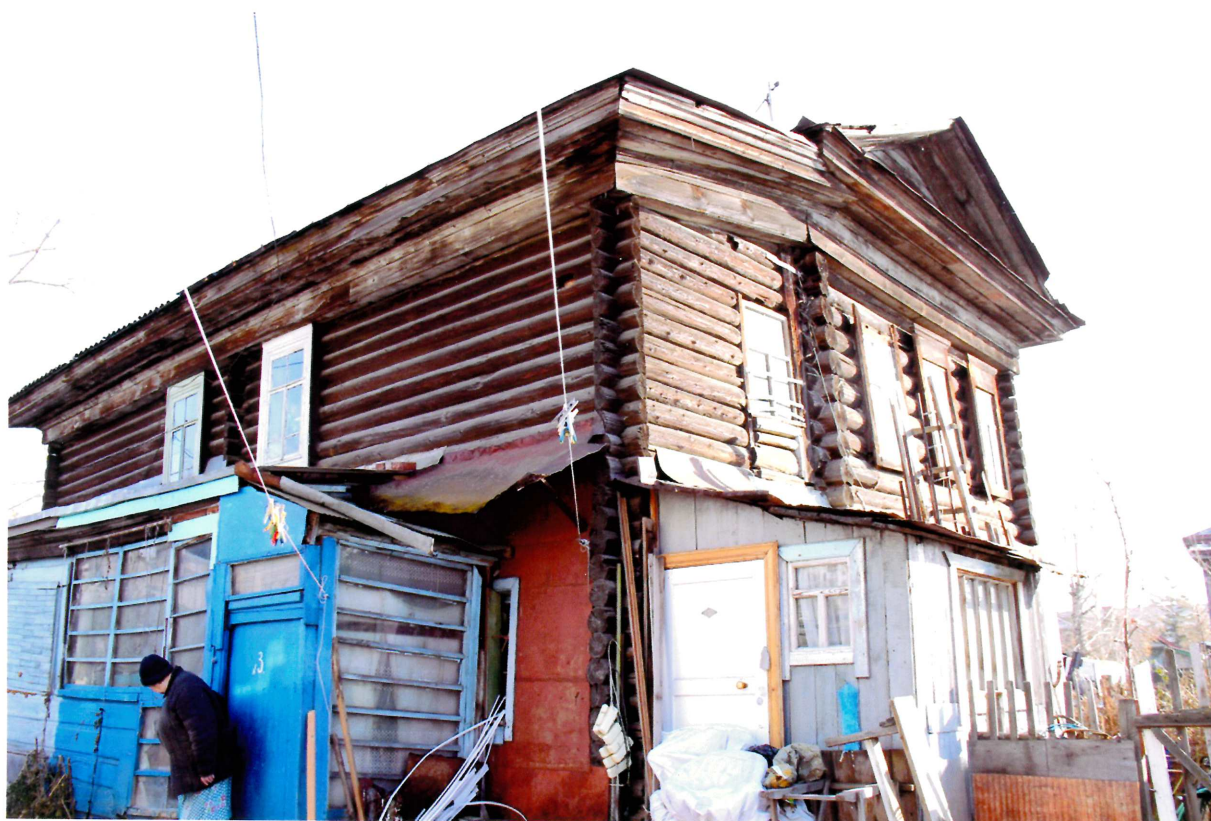
Видовая точка № 4. Северный и западный фасады. Вид со двора.
