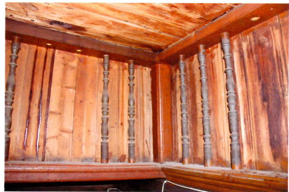
Видовая точка № 9. Ограждение лестничной площадки.
