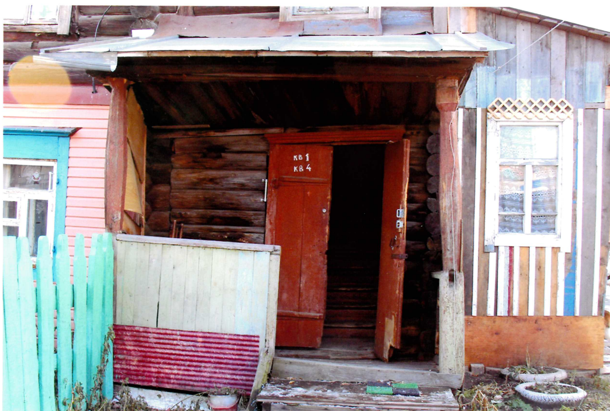
Видовая точка № 3. Крыльцо парадного входа. Главный фасад.
